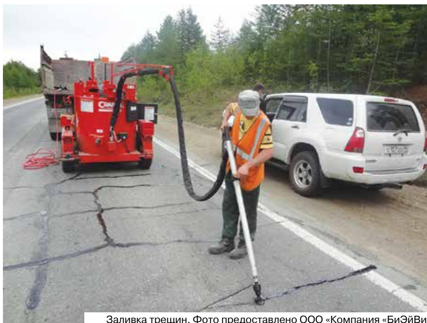
Заливка трещин. Фото предоставлено ООО «Компания «БиЭйВи»
