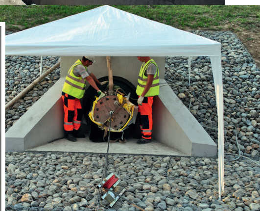
Производственная экскурсия (мост через реку Песчаная) Демонстрация технологии санации труб с помощью светополимерно-тканевого рукава на федеральной трассе Р-256 (М-52)
