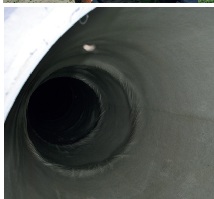
Производственная экскурсия (мост через реку Песчаная) Демонстрация технологии санации труб с помощью светополимерно-тканевого рукава на федеральной трассе Р-256 (М-52)
